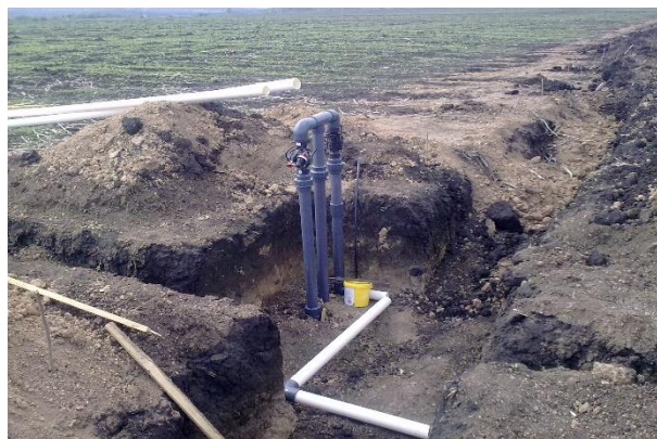
Монтаж трубопроводів системи краплинного зрошення
